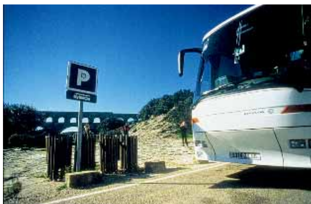
LE PONT DU GARD avant réhabilitation
