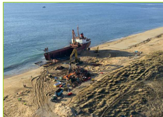
Chantier de démantèlement © Laurent Mignaux/MEDDE-METL
