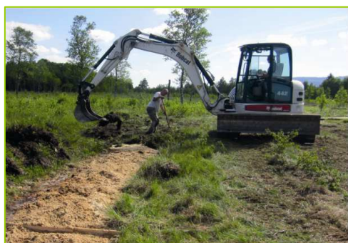
Travaux de fermeture d'un fossé ©Geneviève Magnon
