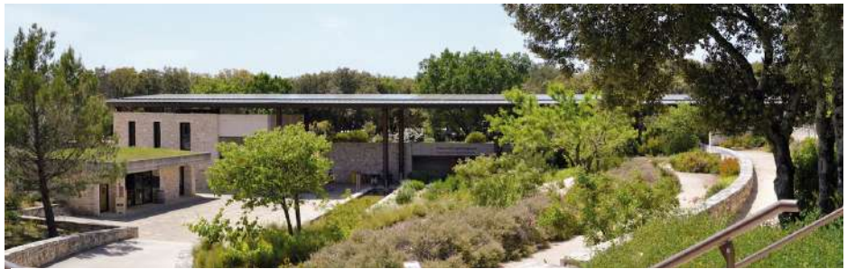
Le bâtiment d'accueil du Grand Site de France Aven d'Orgnac, au cœur du site classé, accueille discrètement des panneaux photovoltaïques couvrant 40% des besoins de la grotte. Une nouvelle installation est envisagée sur le toit du bâtiment administratif. © Françoise Prudhomme – Aven d'Orgnac
