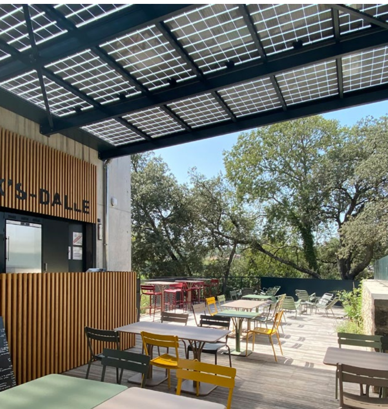
Ombrière photovoltaïque dans une maison de site des Gorges du Gardon
