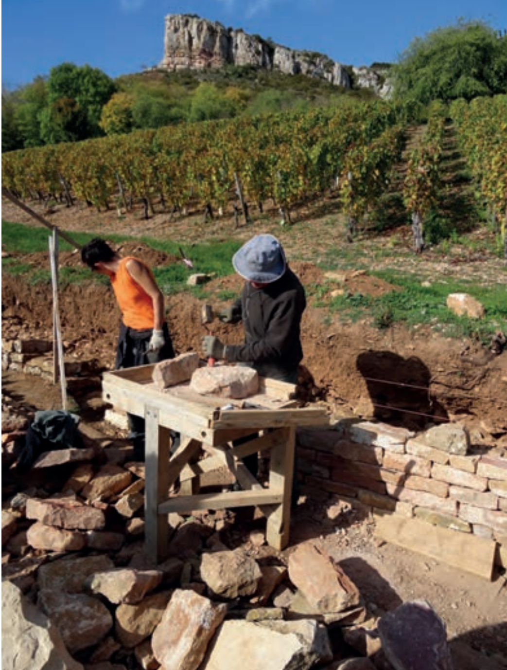
■ Chantier de restauration d'un mur en pierres sèches dans le Grand Site de France Solutré Pouilly Vergisson. © Département de Saône-et-Loire
