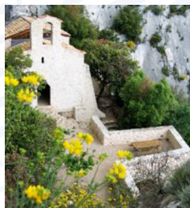
Chapelle St Ser : mise en sécurité par des murets bâtis en pierre sèche
