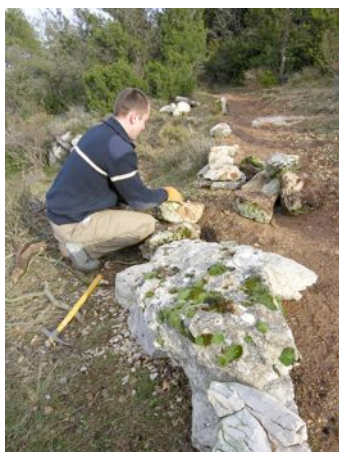
Construction d'un muret de mise en défens
