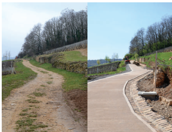
OPP du Grand Site de Solutré-Pouilly-Vergisson. Photo Avant/après du chantier du chemin du Site. 2015.
