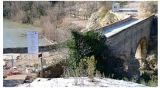
Le pont du Diable en restauration
