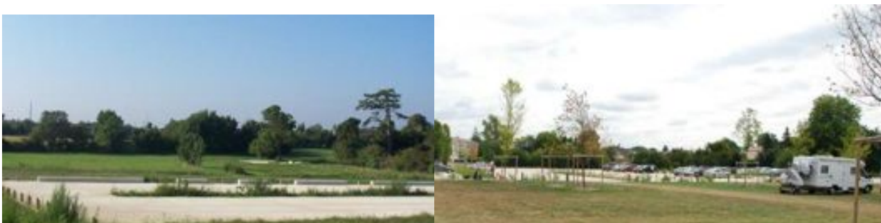
Exemple d'aire de stationnement créée à Arçais et réaménagée à Coulon (2009), en entrée de bourg, pour limiter les véhicules dans le cœur du village et le marais. L'aménagement respecte l'esprit des lieux : forte présence du végétal, matériaux calcaires naturels n'imperméabilisant pas les sols, et échelle correspondant au site.
