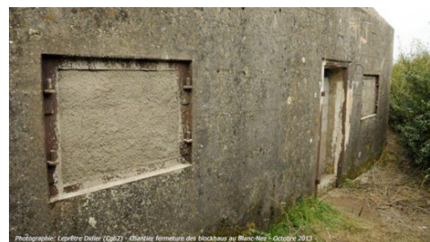
Photographie : Leptère Didier (CG62) - Chantier fermeture des bunkers au Blanc-Nez - Octobre 2013 © CG62 /D. Lepêtre Murage d'un bunker au Blanc-Nez, 2013
