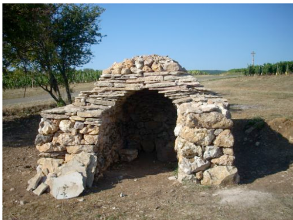
© SMGS Patrimoine vernaculaire en pierre sèche restauré par la brigade, à Solutré : Cadole La Roue
