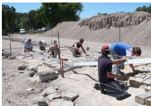
Photo Ph. Deliau © CG66 / P.Deliau Chantier à Paulilles, 2008
