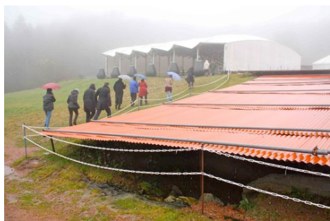
© RGSF/ L. Pára Tôlage des chantiers de fouilles pour la protection hivernale des vestiges
