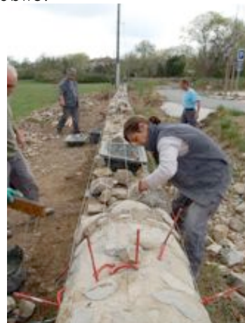
© SMGG / M.Bauza Restauration de 20 m de couronnement de parapet de mur
