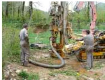
*Forage et installation des pompes à chaleur et captages verticaux*
