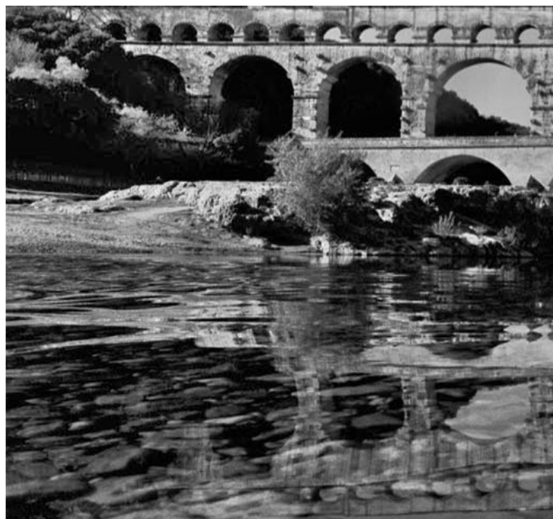
Josef Koudelka Le pont du Gard - 2015 - Magnum photo / Photo réalisée dans le cadre de la carte blanche à l'occasion du 30ème anniversaire de l'inscription du monument au patrimoine mondial par l'UNESCO
