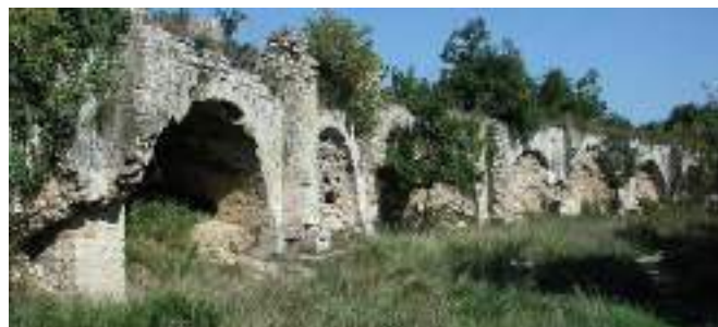
Horizon provence Vestiges de l'aqueduc de Nîmes
