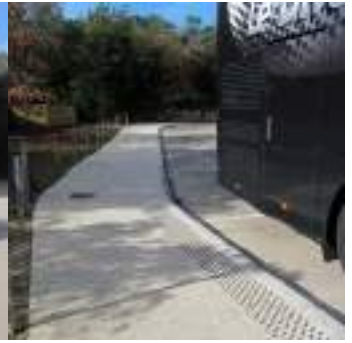
EPCC Mise en accessibilité PMR
