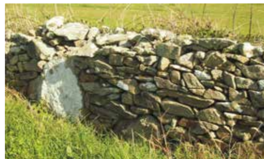
Muret de pierres sèches
