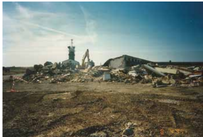
Travaux de démolition
