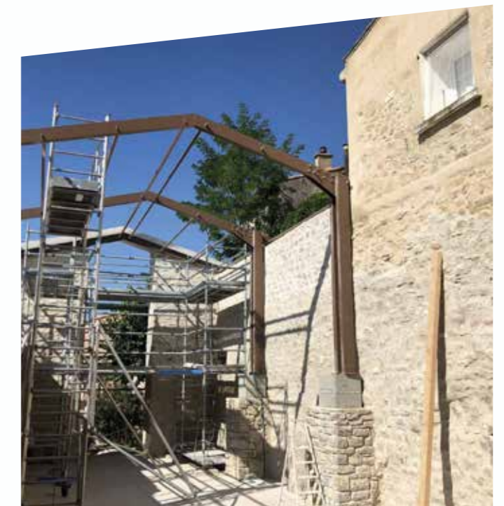
Restauration et reconstruction de la structure métallique pour la chapelle Sainte Marie à Puyloubier (source : www.cerni.fr )
