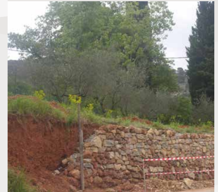
Muret en pierres sèches en cours de restauration le long de la Route Cézanne (source : © GSSV)
