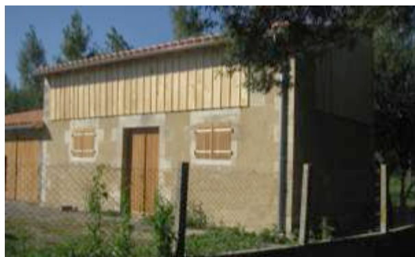
Après : Restauration sobre, évitant la démolition.
