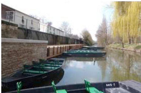
Quais après intervention.
