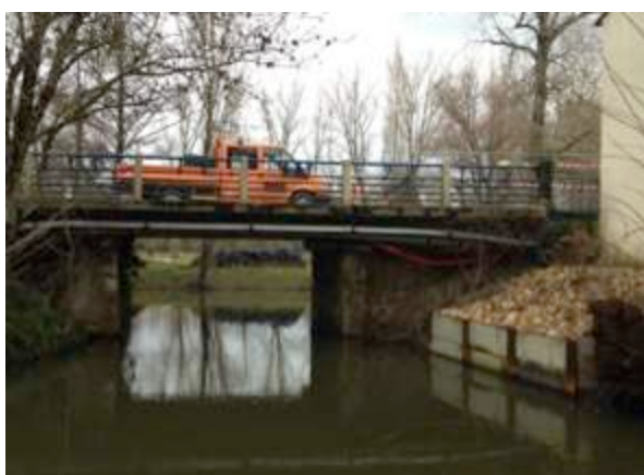
Avant : pont - traitement routier, réseaux apparents.
