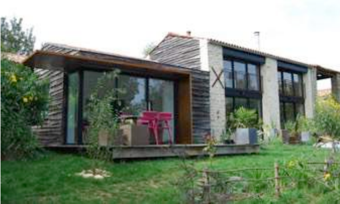
Réhabilitation d'une ancienne grange en habitation, dans un village-rue.
