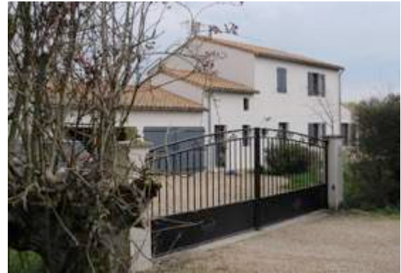
Construction neuve, en lisière urbaine, inspirée de l'architecture locale.
