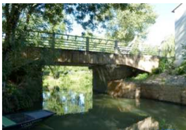
Après : pont - bardage bois et végétalisation.
