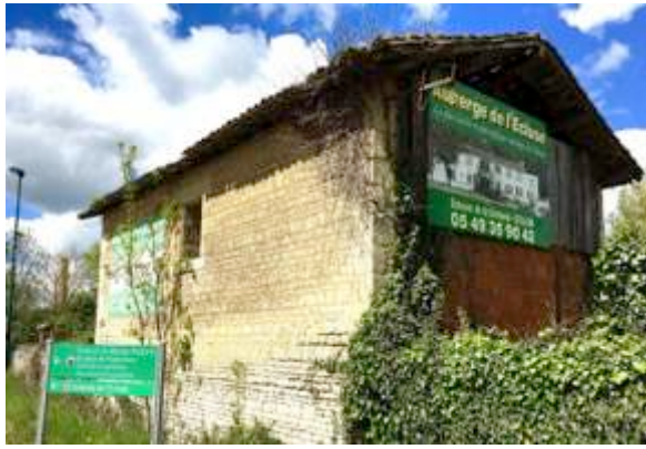
Avant : Coulon, face au parking d'accès aux quais.
