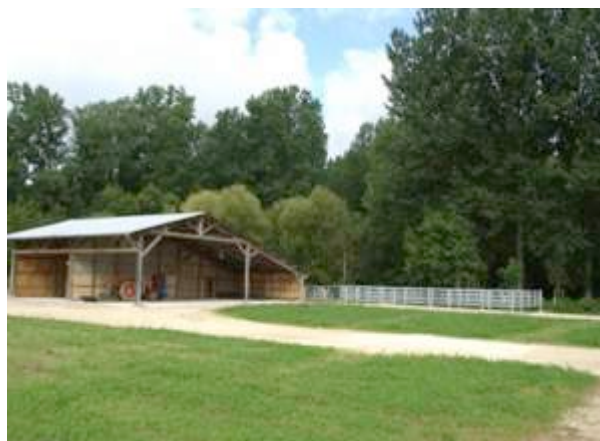
Après : scierie réhabilitée en port technique d'entretien du marais.
