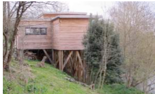
Construction contemporaine, en secteur urbain, dans le site classé à Niort.
