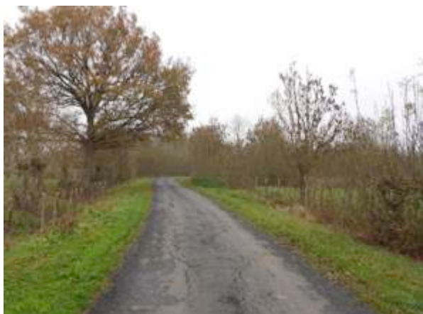
Avant : exemple de route communale en enrobé (Saint-Pierre-le-Vieux).
