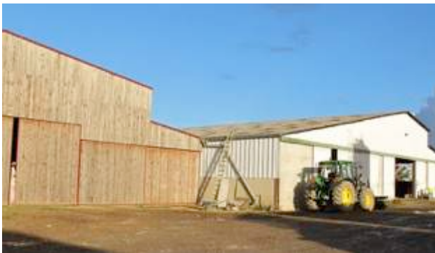
Extension de bâtiments agricoles, en bardage bois, d'un siège d'exploitation existant.
