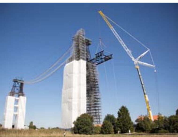
Travaux de restauration 2017 © Simon David - CARO
