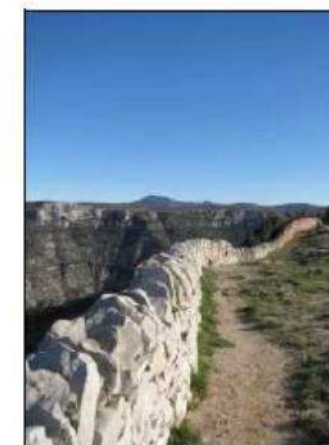
Environ 100 mètres de muret rénové
