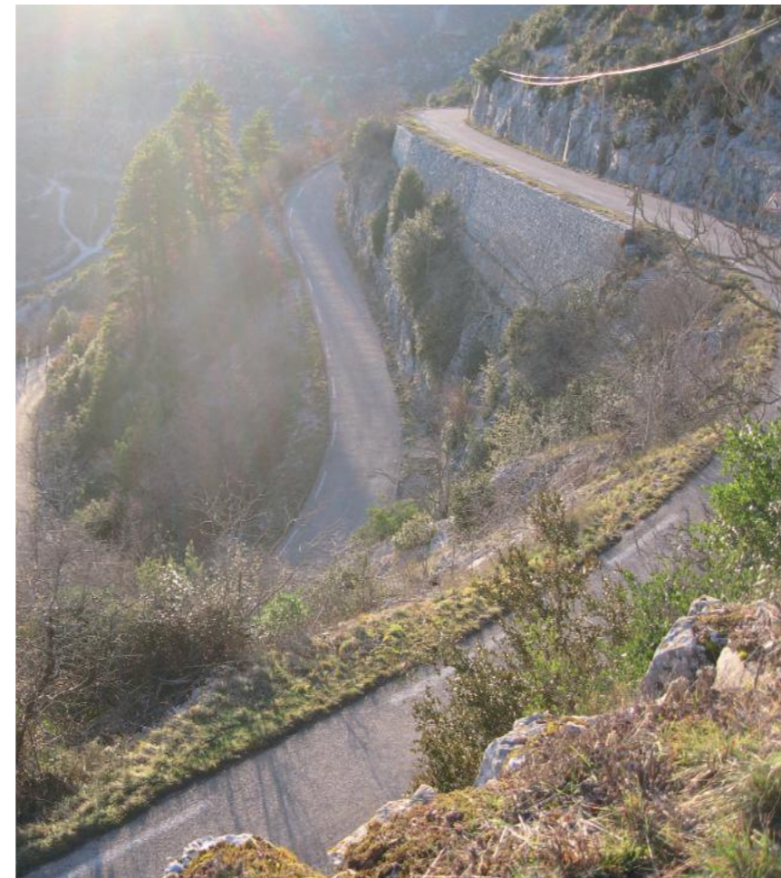
Les lacets de la RD 713 à proximité des travers de Navacelles
