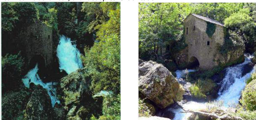
Les Moulins de la Foux, avant et après réhabilitation
