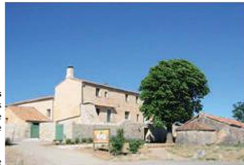
La maison de site de la Baume Auriol après réhabilitation
