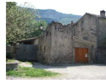
Le bâtiment acheté par la commune de Saint-Maurice-Navacelles
