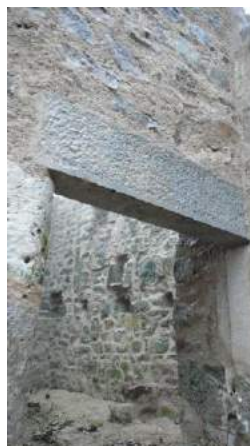
Travaux de stabilisation
